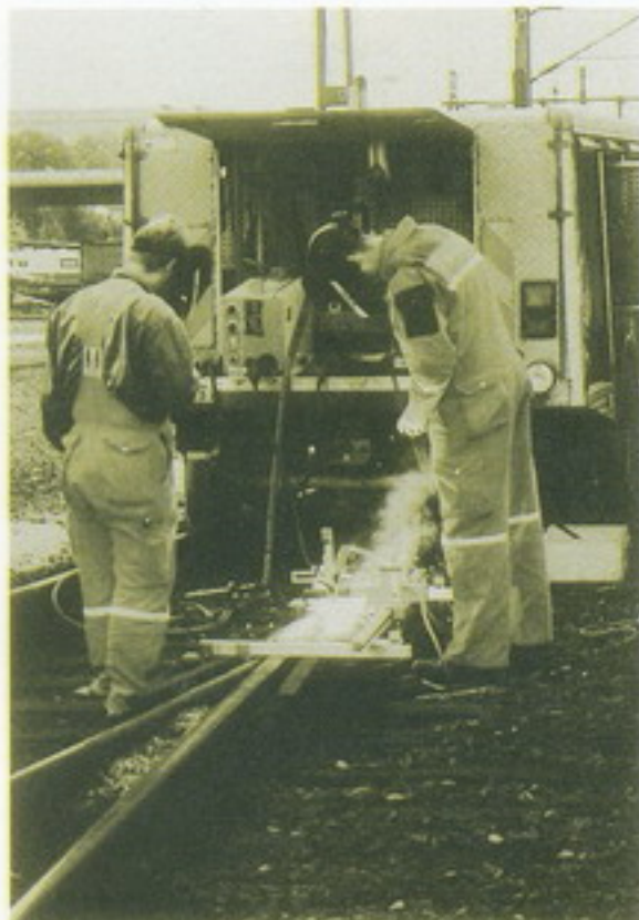
Încărcare prin sudare mecanizată: Railtrac BV/OK Tubrodur 15.43
