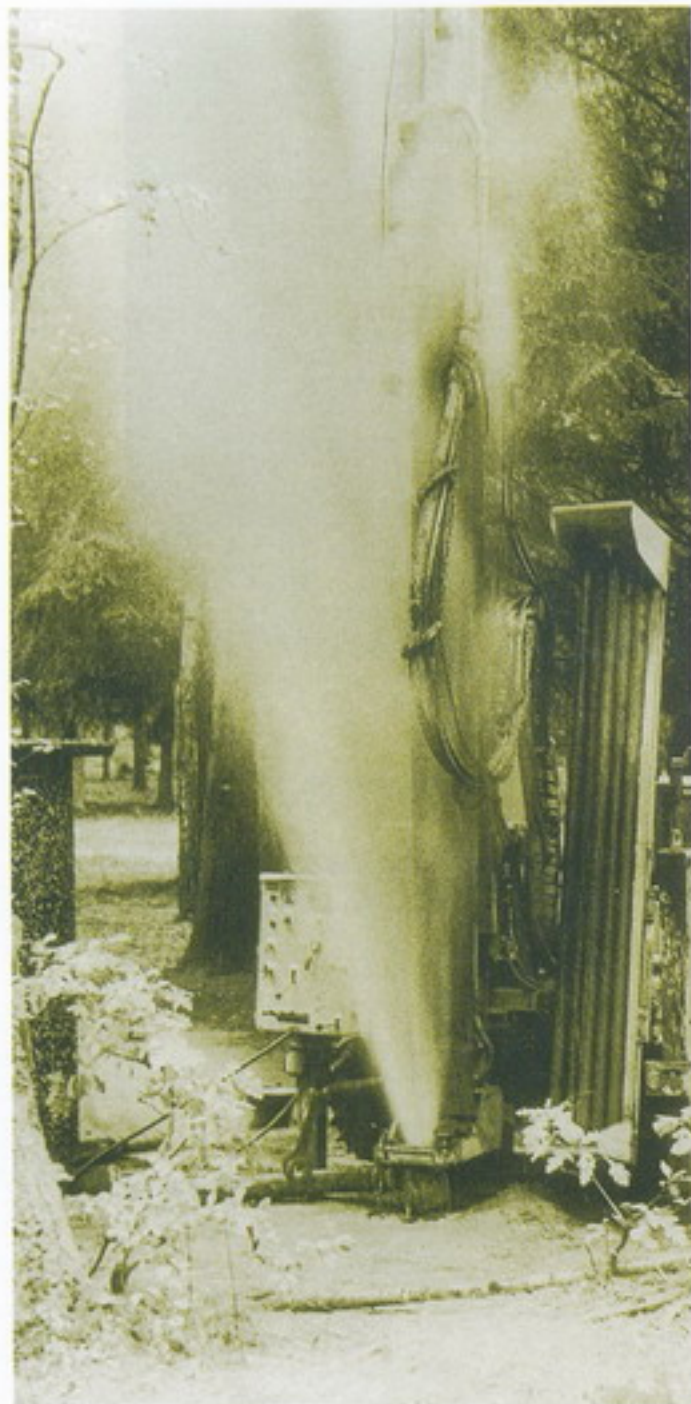
Repararea utilajelor de forat în sol: OK 83.28 pentru refacerea formei OK84.84 pentru încărcare dură
