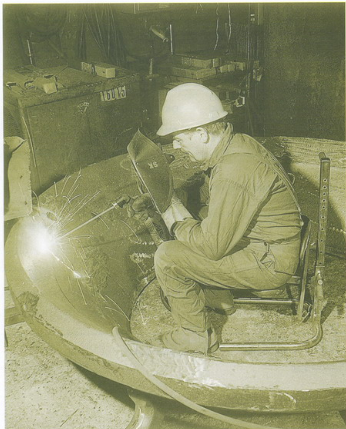
Repararea concasorului din oțel cu 14% Mn utilizând electrodul OK 86.08
