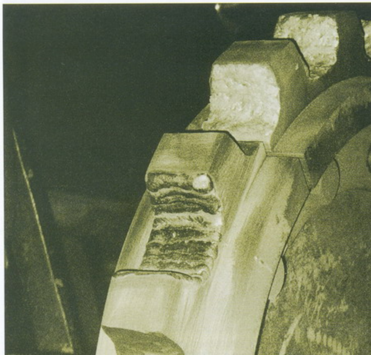
Roata dințată de angrenare: Întreținerea preventivă, electrod OK 83.28
