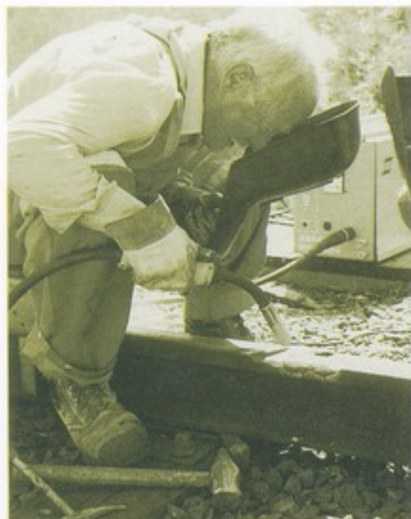
Repararea arsurilor de suprafață: OK Tubrodur 15.43
