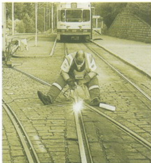
Repararea șinelor de tramvai: OK 67.52
