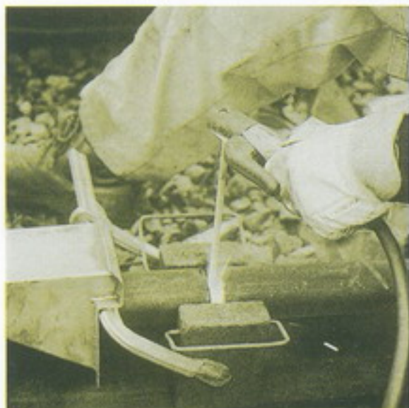
Cordoanele sudate de îmbinare ale șinelor: OK 74.78
